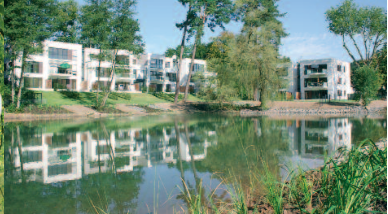
Von Balkonen und Terrassen der neuen Wohnhäuser genießt man einen idyllischen Ausblick auf den historischen Schlossteich
