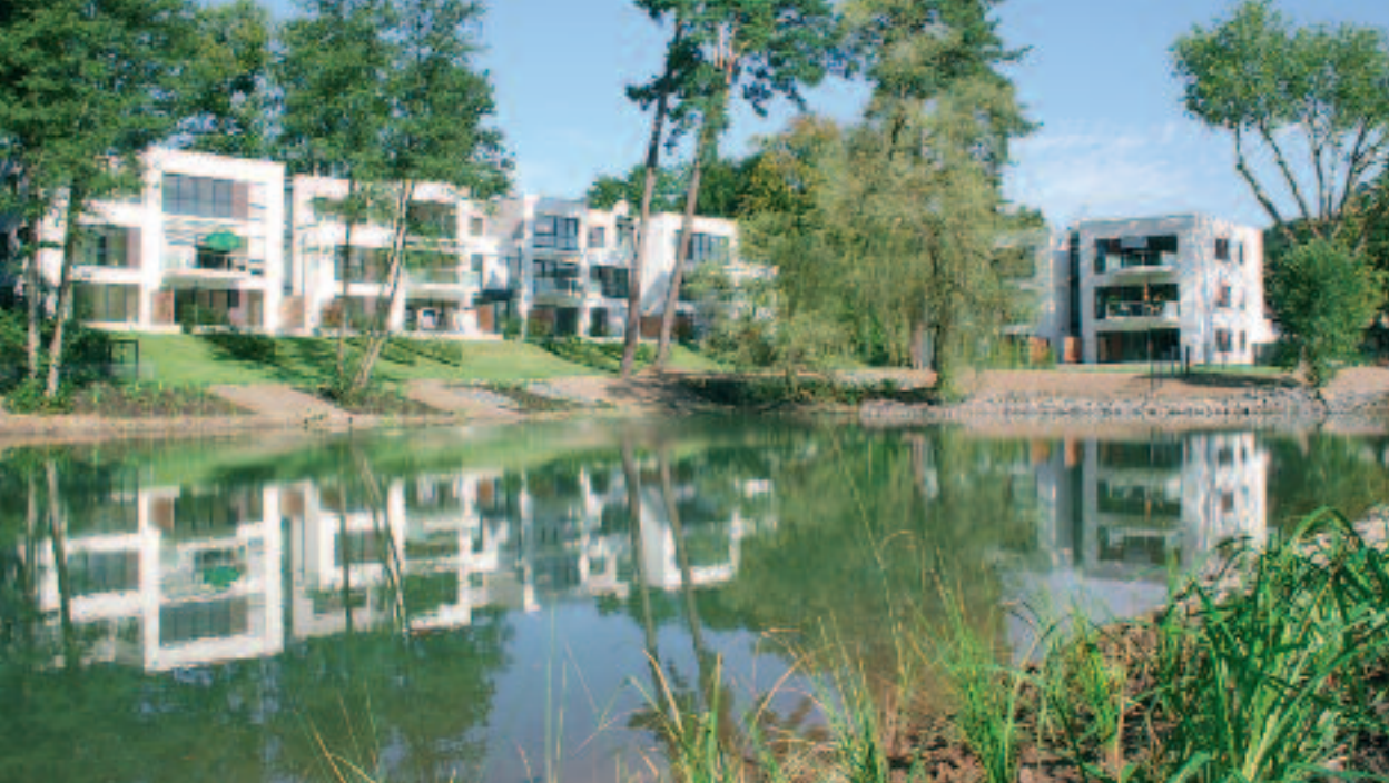
Von Balkonen und Terrassen der neuen Wohnhäuser genießt man einen idyllischen Ausblick auf den historischen Schlossteich
